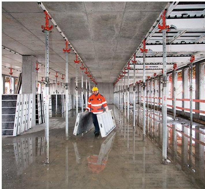
Le **COUVRE-JOINT** est conçu pour combler l'espace entre les panneaux de dalle de coffrage et restera en place quelques jours après le démontage du système SKYDECK.
